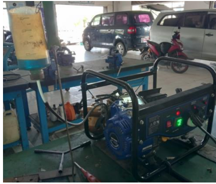
Gambar 15. Proses Pengujian Pada Mesin Genset
