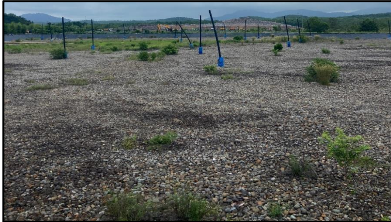
Gambar 7. Material Penutup berupa Batu Kali Pada Area Sel TPA Regional Banjarbakula
